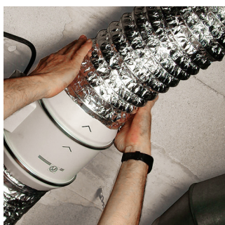
Montaż kanałów wentylacyjnych
