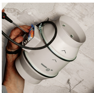
Przyłączenie przewodów zasilania
