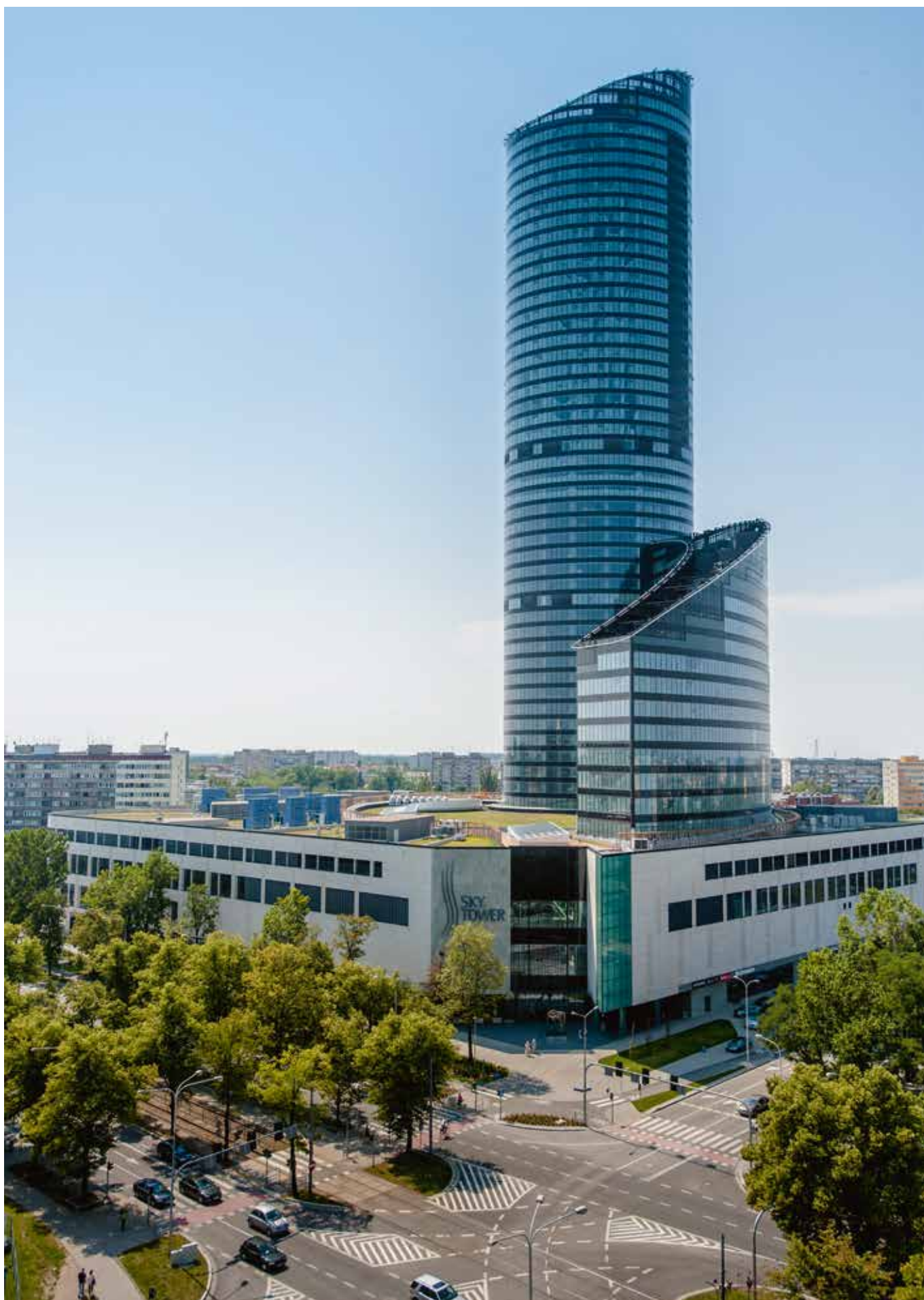
Oddymianie w budynku SKY TOWER we Wrocławiu – 12 szt. DVVI 1000
