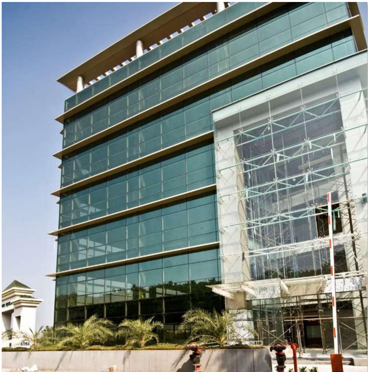
Obiekt: Clover Highland Typ budynku: Biurowiec, Galeria Handlowa Miasto/Kraj: Pune, Indie Urządzenia: Wentylatory (K), Jet Fans, Osiowe.
