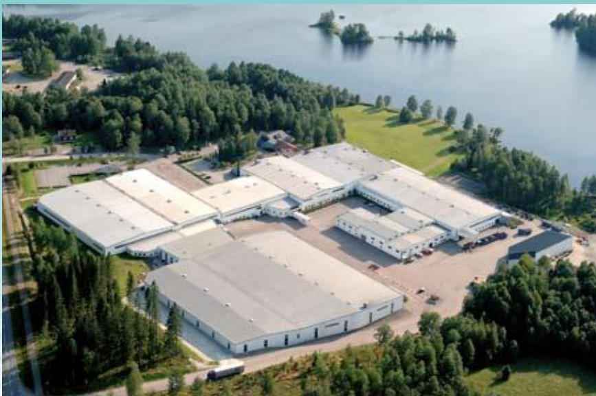
Siedziba głównej Grupy Systemair, a także główny zakład produkcyjny mieści się w Skinnskatteberg w Szwecji. Produkcja opiera się na całkowicie zautomatyzowanej nowoczesnej linii produkcyjnej wyposażonej w zaawansowane rozwiązania techniczne. Również tu mieści się laboratorium badawcze i pomiarowe.
