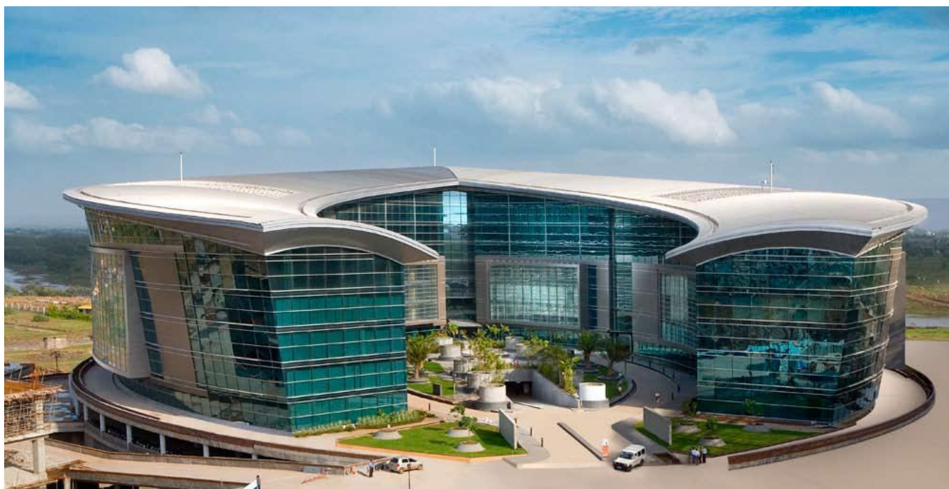
Obiekt: EON Kharadi Miasto/Kraj: Pune, Indie Urządzenia/Rozwiązania: MUB, Wentylatory K, KD, Osiowe, Kratki
