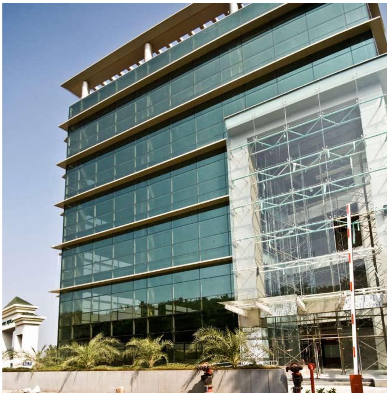
Obiekt: Clover Highland Typ budynku: Biurowiec, Galeria Handlowa Miasto/Kraj: Pune, Indie Urządzenia: Wentylatory (K), Jet Fans, Osiowe.
