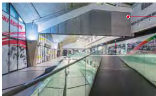
wydzielony obszar - kurtyny połączone kątowno z wyjściem ewakuacyjnym
