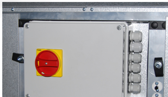
Puszka do podłączenia opcjonalnych elementów automatyki oraz wyłącznik główny z przyłączem zasilania.
