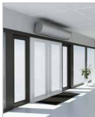
D) Drzwi zamknięte – wentylatory kurtyny wyłączą się po ustawionym czasie opóźnienia.
