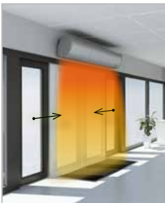
C) Drzwi zamykają się – wentylatory kurtyny nadal pracują ze zwiększoną prędkością obrotową.
