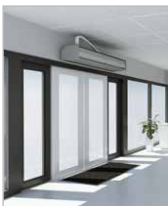
A) Drzwi zamknięte – wentylatory kurtyny nie pracują.
